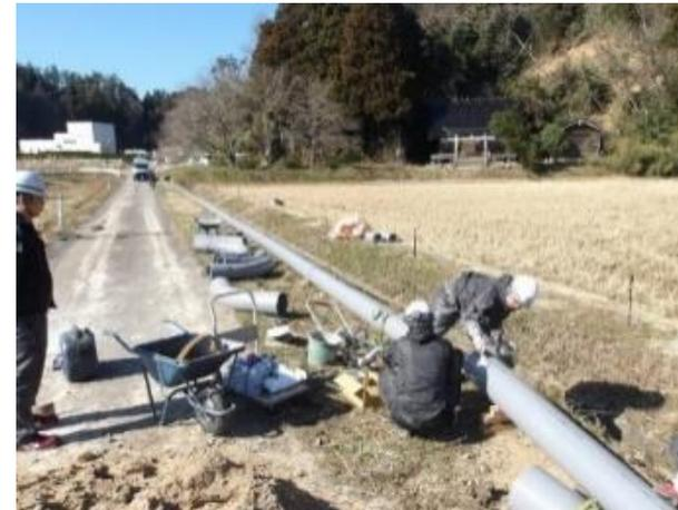
下水を集約し処理場へ送る圧送管の被災現場（珠州市）
